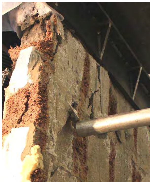
Figura 16. Pannello 2-CC14_01: Il pannello dopo la prova di compressione centrata.
