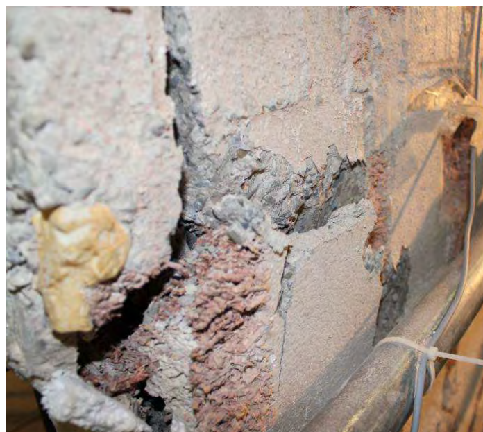
Figura 18. Pannello 2-CC14_02: Il pannello dopo la prova a compressione centrata.
